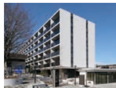
KNOCKSみなまきみらい 発注者:相鉄不動産(株)
