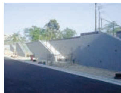
戸塚区北街区・西街区計画宅地造成 発注者:住友不動産(株)・(株)大和地所
