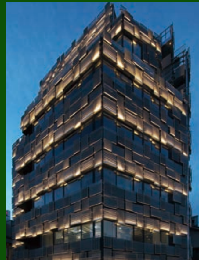
デリス横浜ビル 発注者: (株) デリス建築研究所
