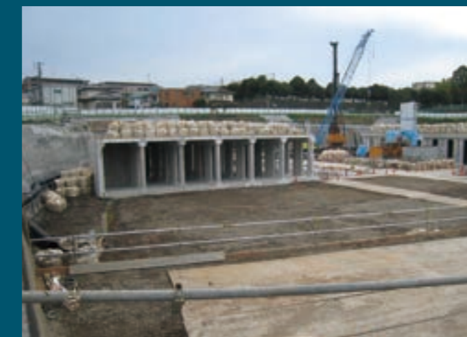
弥生台集合住宅計画に伴う地下遊水池工事 発注者:相鉄不動産(株)
