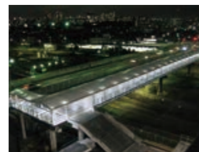
新鶴見機関区構内鹿島田線 人道橋新設その他(橋面)工事 発注者:東日本旅客鉄道(株)
