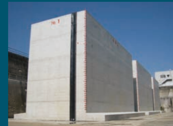
南本牧ふ頭ケーソン製作工事 発注者:横浜市
