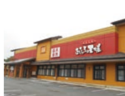
おふるの王様 町田店改装工事 発注者:東京建物リゾート(株)
