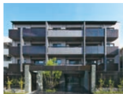
オープンレジデンス桜新町テラス 発注者:(株)オープンハウス・ディベロップメント
