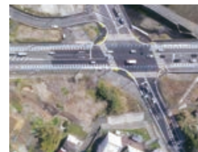
市道と泉町第449号線道路改良工事 発注者:横浜市
