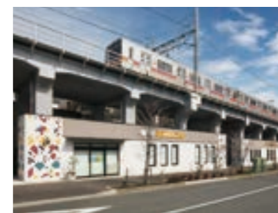
大井町線大井町駅～下神明駅間高架下店舗 発注者:東京急行電鉄(株)
