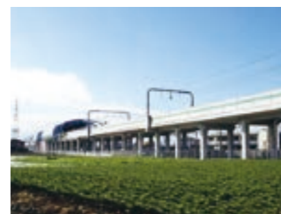
いすみ野線第3期新線建設工事 発注者:相模鉄道(株)
