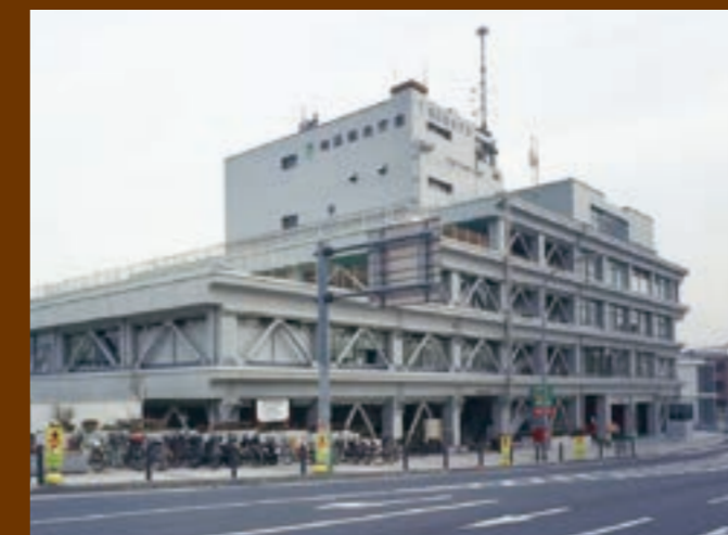
旭区総合庁舎改修(耐震)工事 発注者:横浜市
