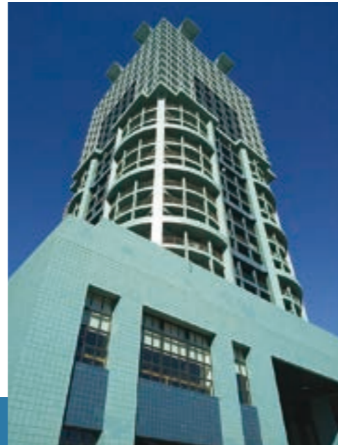
なぎさニュータウン1・2・3号棟 東京都 江戸川区 14階3棟 / 488戸 SRC造 2020年竣工
