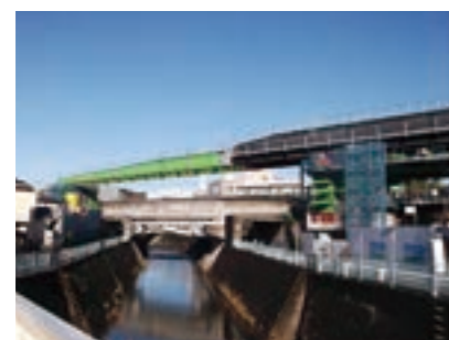
相鉄・東急直通線 西谷駅留置線新設工事(土木関係) 発注者:相模鉄道(株)
