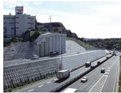
横浜新道拡幅工事 発注者:東日本高速道路(株)
