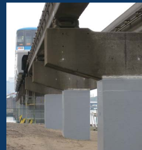
東京モノレール耐震補強工事 発注者:モノレールエンジニアリング(株)
