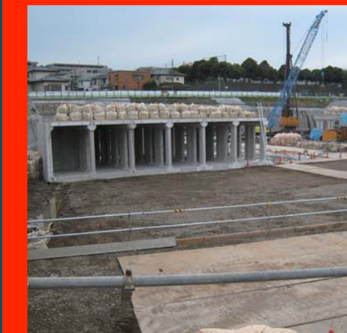
弥生台集合住宅計画に伴う地下遊水池工事 発注者:相鉄不動産(株)
