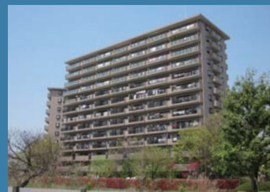
ヴェルシティ古河 茨城県 古河市 14階/319戸 SRC造 2012年竣工
