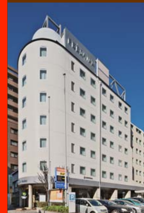
相鉄フレックスイン 東京東陽町リノベーション工事 発注者:(株)相鉄イン開発
