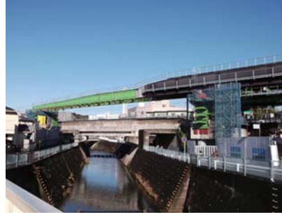
相鉄・東急直通線 西谷駅留置線新設工事(土木関係) 発注者:相模鉄道(株)
