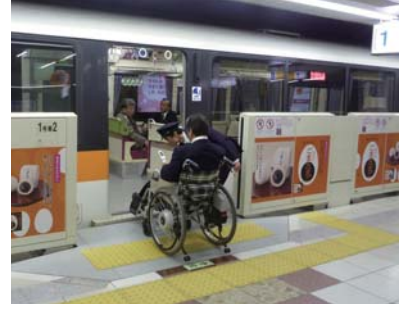
各駅ホーム車椅子対応スロープ設置工事 発注者:モノレールエンジニアリング(株)
