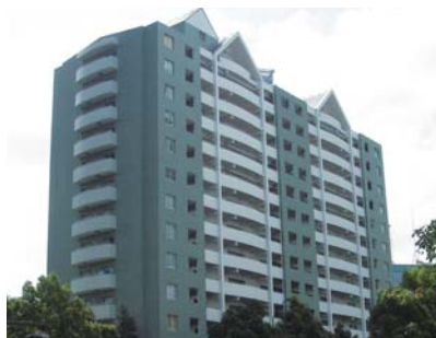
ロア式番館大規模修繕工事 発注者:ヨコハマポートサイドE-2街区 ロア式番館部会
