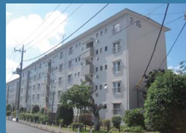
左近山団地二街区住宅 横浜市 旭区 5階/500戸 RC造 2012年竣工
