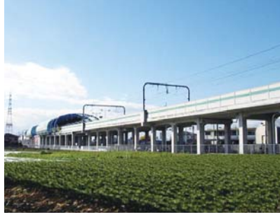
いずみ野線第3期新線建設工事 発注者:相模鉄道(株)
