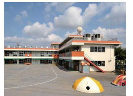
こばやし幼稚園改修防音工事 発注者:学校法人 秋葉台学園
