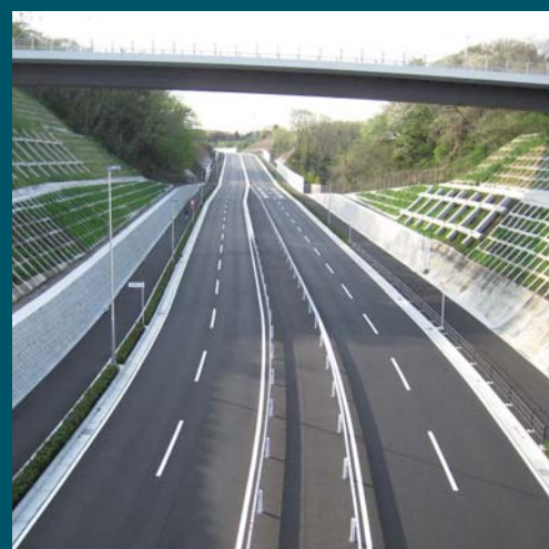
都市計画道路戸塚遠藤線街路整備工事 発注者:横浜市
