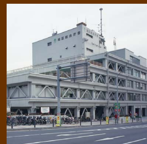
旭区総合庁舎改修(耐震)工事 発注者:横浜市
