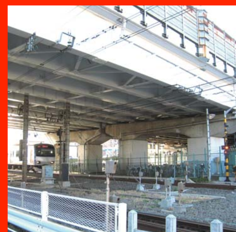
本町向米橋外取備強工事 発注者:相模鉄道(株)
