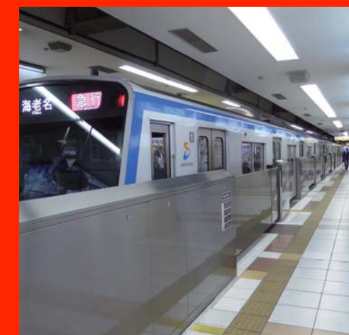
可動式ホーム設備設置工事(横浜線) 発注者:相模鉄道(株)
