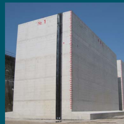
南本牧ふ頭ケーソン製作工事 発注者:横浜市
