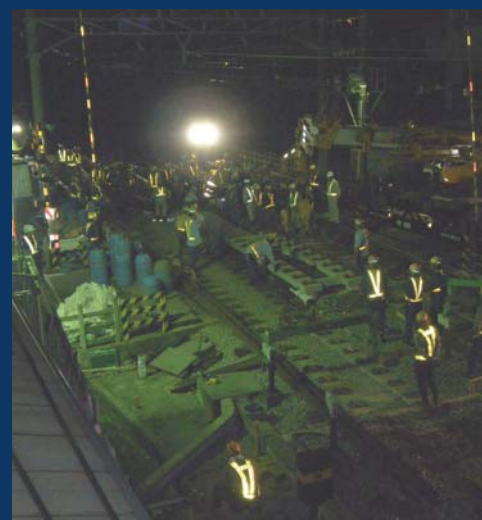
希望ヶ丘1号踏切道拡幅工事 発注者:相模鉄道(株)
