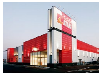
あたりや上里店新築工事
