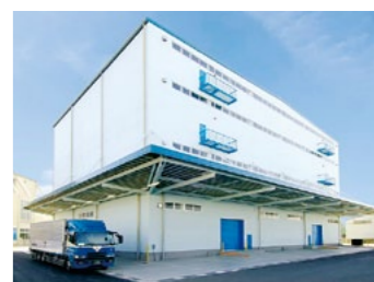
丸山運輸倉庫株第五倉庫新築工事
