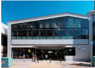
東横線綱島駅高架下店舗新設 発注者: 東急電鉄(株)
