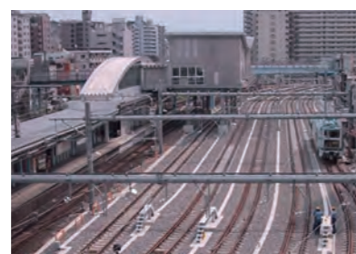
星川・天王町駅付近連続立体交差工事 (西横浜工区・軌道関係) 発注者:相模鉄道(株)
