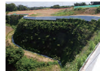
舞岡墓園整備工事 発注者:横浜市
