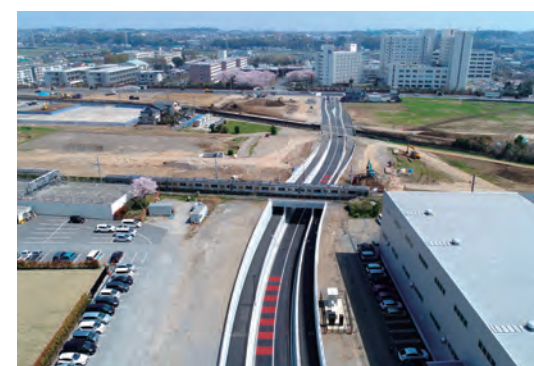
市道53号線バイパス道路新設工事(その1)
