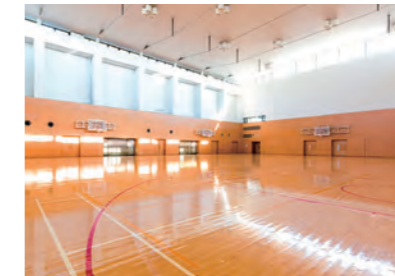
フェリス女学院体育館天井耐震補強 発注者: 学校法人フェリス女学院大学
