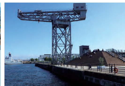
みなとみらい21新港地区ハンマーヘッドパーク整備工事
