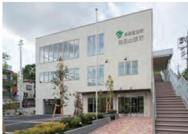
多摩区役所生田出張所建替事業 発注者: 川崎市
