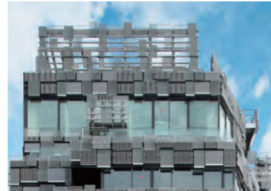
デリス横浜ビル 発注者: (株)デリス建築研究所
