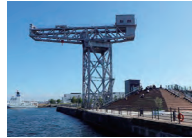
みなとみらい21新港地区 ハンマーヘッドパーク整備工事 発注者:横浜市
