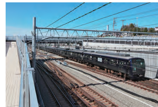
相鉄・東急直通線西谷駅留置線新設工事他
