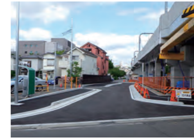
市道鶴ヶ峰天王町線道路改良工事 発注者:横浜市
