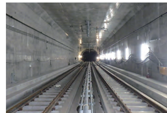
相鉄・JR直通線西谷トンネル建設工事
