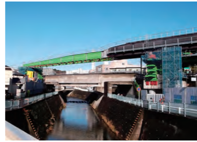
相鉄・東急直通線西谷駅留置線新設工事 (土木関係) 発注者:相模鉄道(株)
