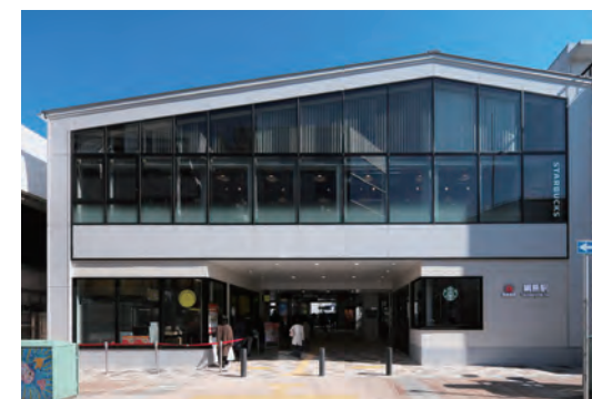
東横線綱島駅高架下店舗新設
