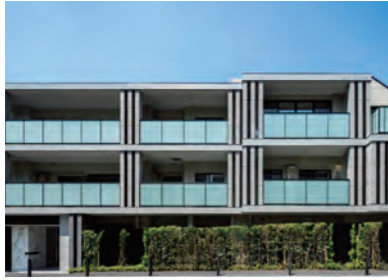
オープンレジデンス島津山コート 発注者: (株)オープンハウス・ディベロップメント
