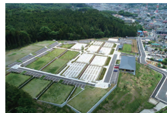
公園墓地川井聖苑計画造成工事
