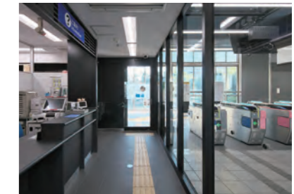
南万騎が原リノベーション工事 (駅舎棟・建築関係) 発注者: 相模鉄道(株)
