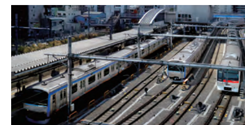
星川天王町駅付近連続立体交差工事
