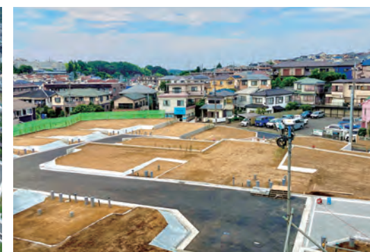
「(仮称)横浜市旭区金が谷一丁目戸建計画」第1期宅地造成工事
