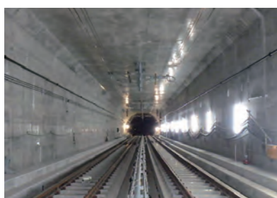
相鉄・JR直通線西谷トンネル建設工事 (軌道関係) 発注者:相模鉄道(株)
