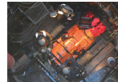
相模鉄道本線鶴ヶ峰9号踏切付近 配水管移設工事 発注者:相模鉄道(株)
