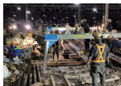
分岐器交換工事 発注者:相模鉄道(株)
