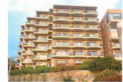
サニー Crest 伊東 構造規模: SRC造13階3棟 戸数: 292戸
