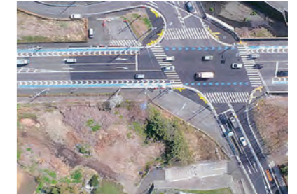
市道と泉町第449号線道路改良工事 発注者:横浜市
