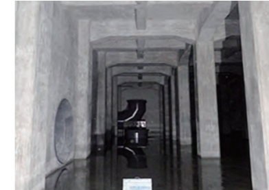
相模原浄水場調整池(2)1号池耐震補強工事 発注者:神奈川県内広域水道企業団
