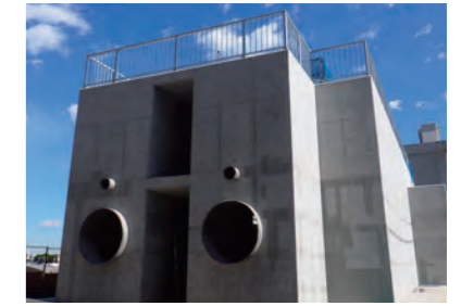
南部水再生センター水処理施設 (第四期)分水槽築造工事 発注者:横浜市
