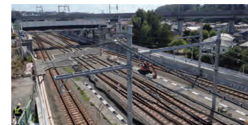
相鉄・東急直通線 西谷駅留置線
