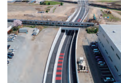
市道53号線バイパス道路新設工事(その1) 発注者:海老名市
